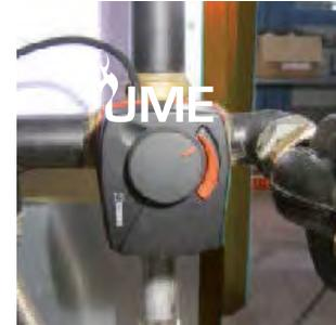
Válvula mezcladora de 4 vías para evitar condensados.
