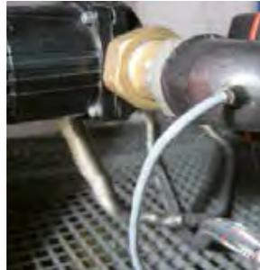
Sonda de temperatura para sistema de calefacción auxiliares (buffer o acumuladores ACS)
